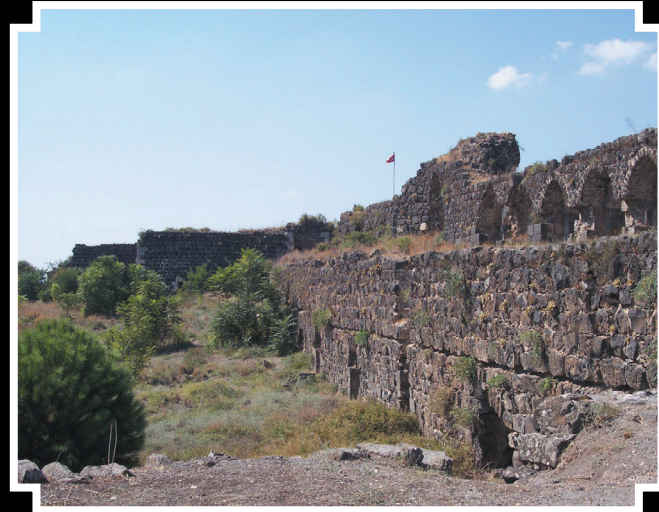
İç kale ve sur duvarları
